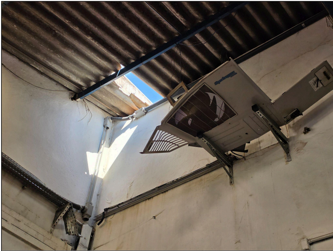
Imagem 8: Telhado com abertura e ar condicionado retirado.
