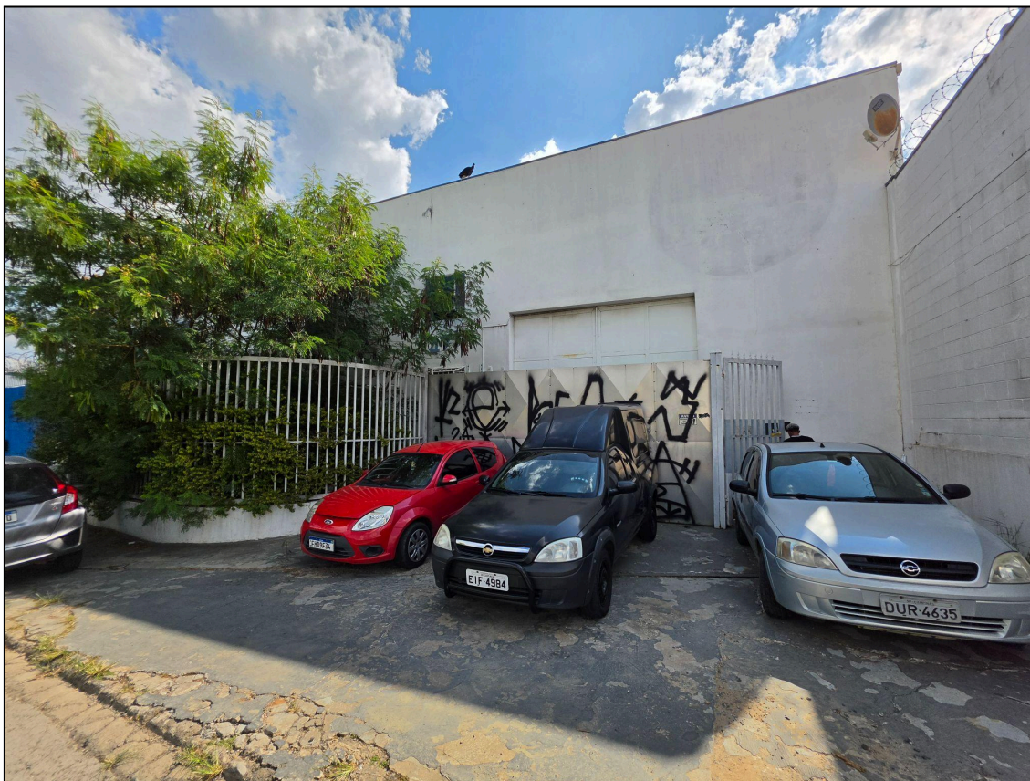
Imagem 20: Fachada do imóvel vandalizada.
