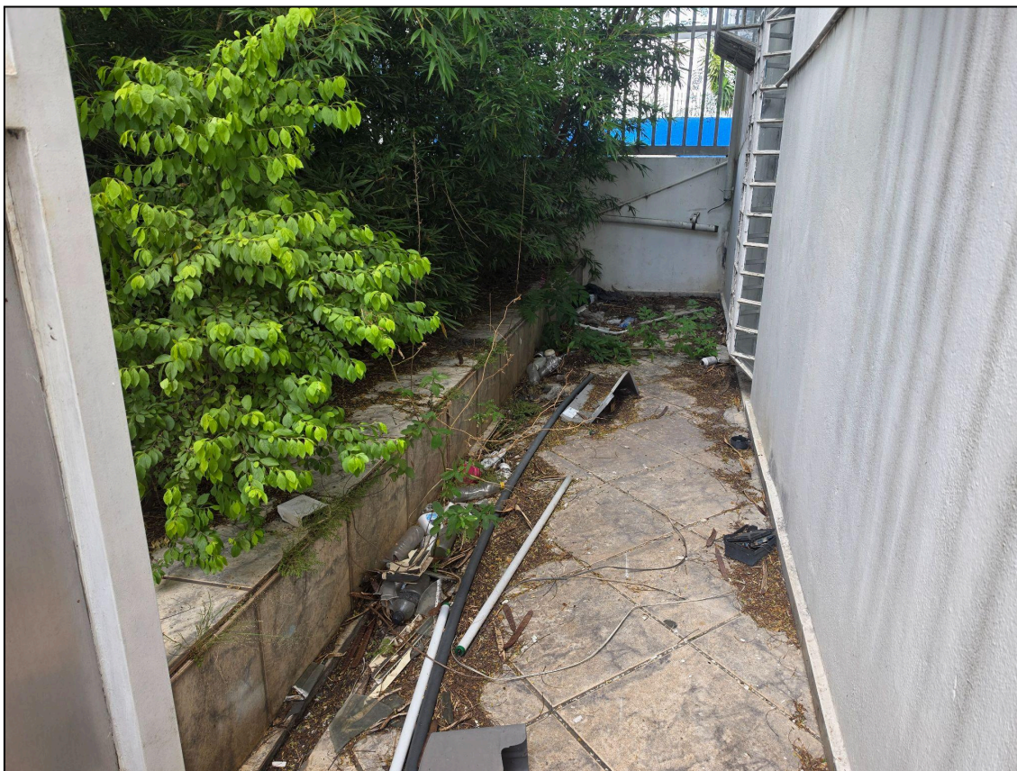
Imagem 18: Itens despejados no acesso do imóvel.
