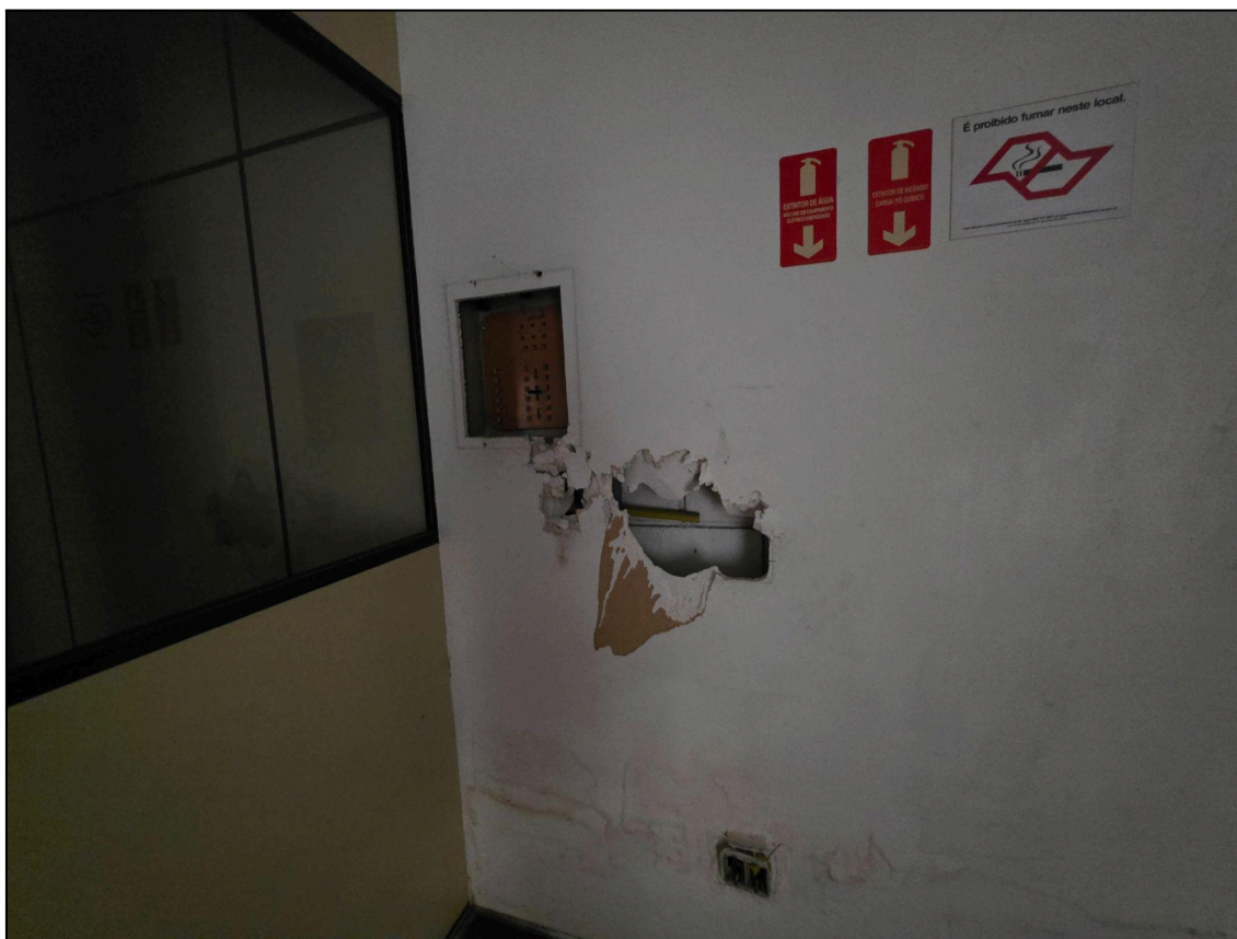
Imagem 14: Abertura da placa para retirada da tubulação/fiação.
