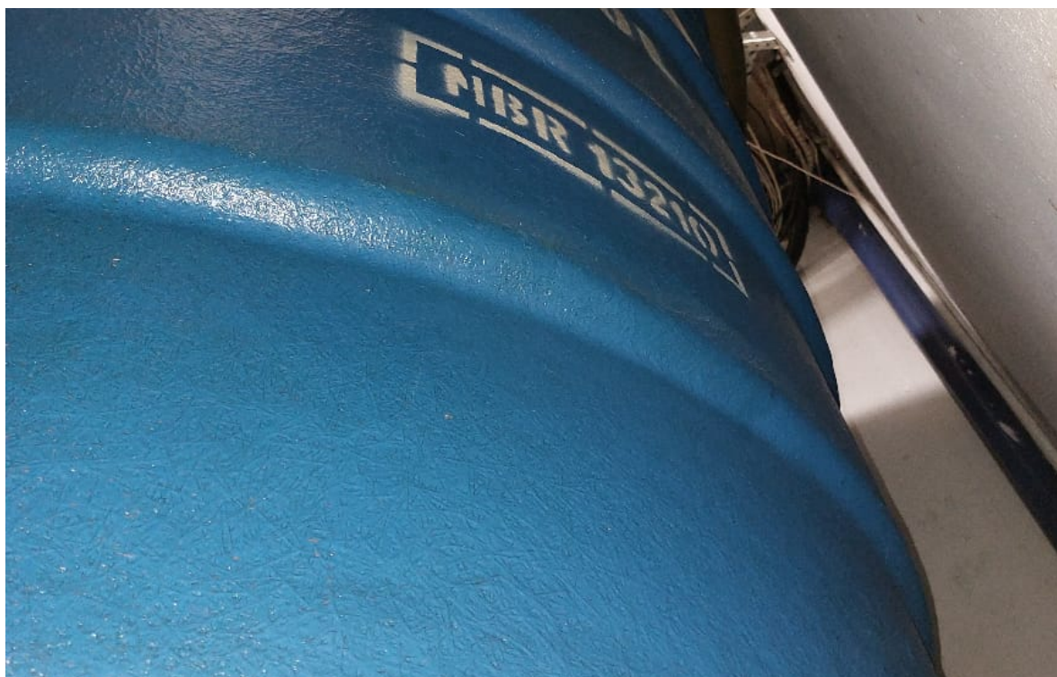
Caixa D'água do reservatório de incêndio
