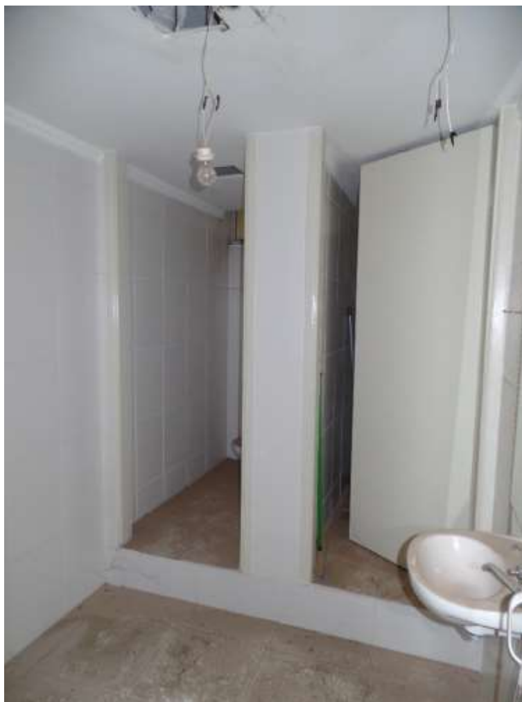
FOTO N.º 63- Vista interna do banheiro de n.º 06.
