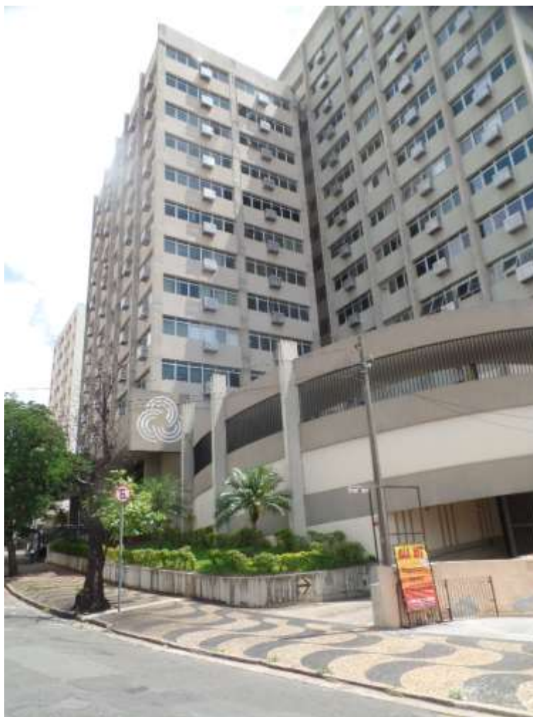
FOTO N.º 04- Tomada da fachada do condomínio para a Rua Barão de Paranapanema.
