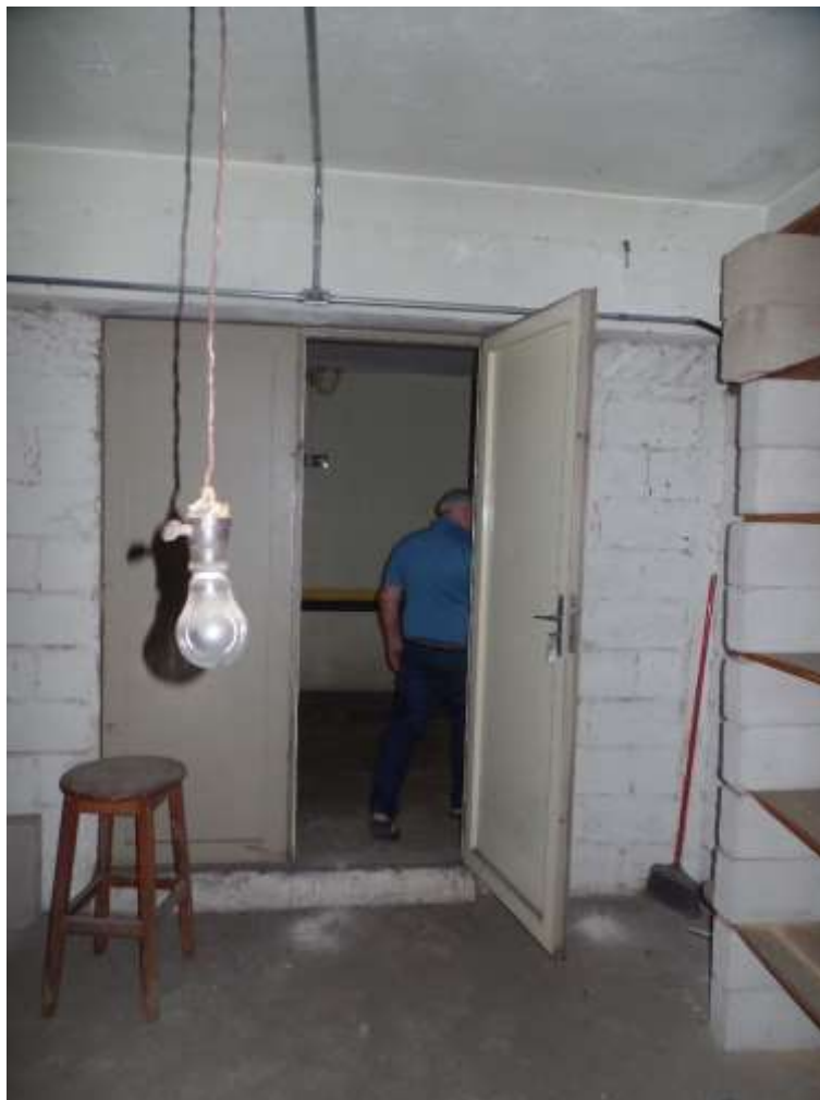
FOTO N.º 16- Aspecto interno do box de garagem de n.º 11, com fechamento com paredes em alvenaria, sendo utilizado como depósito.
