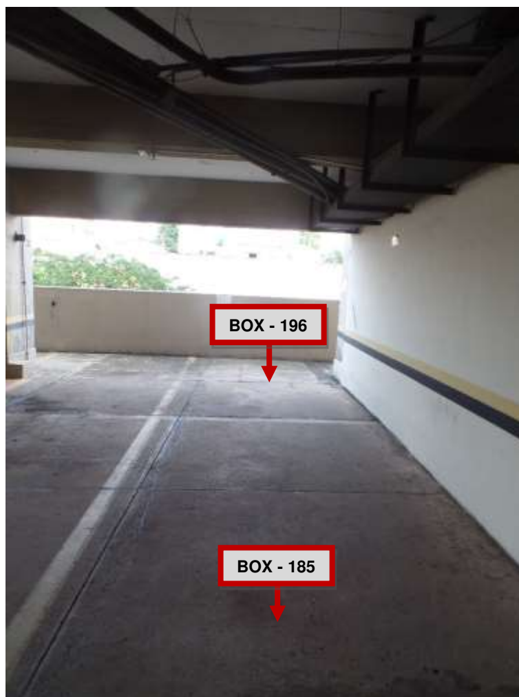
FOTO N.º 24- Detalhe do box de n.º 196 no fundo da vaga e box de n.º 185 na frente.
