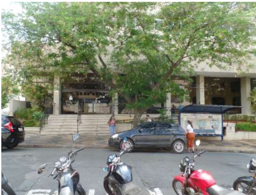
FOTO N.º 07- Detalhe da porta de acesso ao condomínio Governadores de Minas Gerais, feito pela Rua Barão de Paranapanema.
