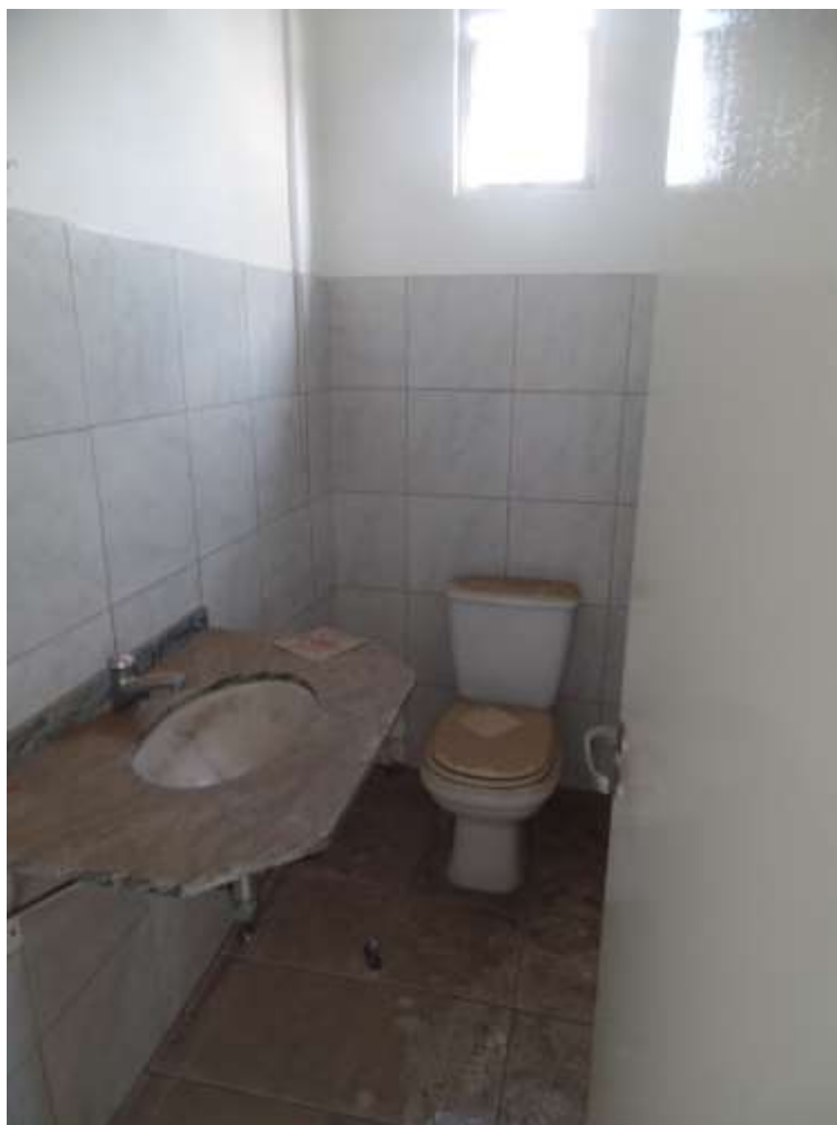
FOTO N.º 60- Tomada do banheiro de n.º 05.
