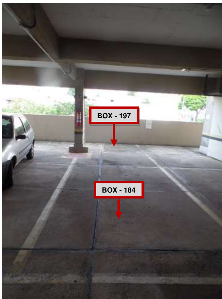
FOTO N.º 23- Aspecto do box de garagem de n.º 197 e box de garagem de n.º 184.
