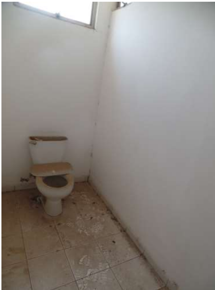
FOTO N.º 53- Aspecto do banheiro de n.º 04.
