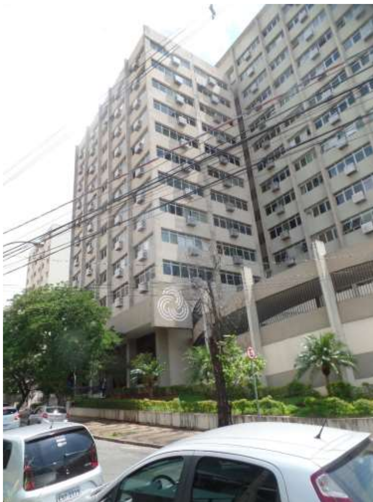
FOTO N.º 03- Vista da fachada do condomínio para a Rua Barão de Paranapanema.
