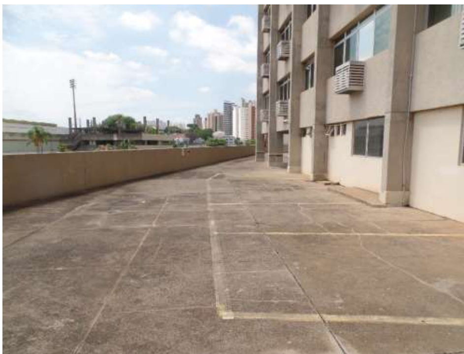
FOTO N.º 40- Tomada geral dos boxes de da garagem descobertas e fechamento com paredes sendo feito escritório.
