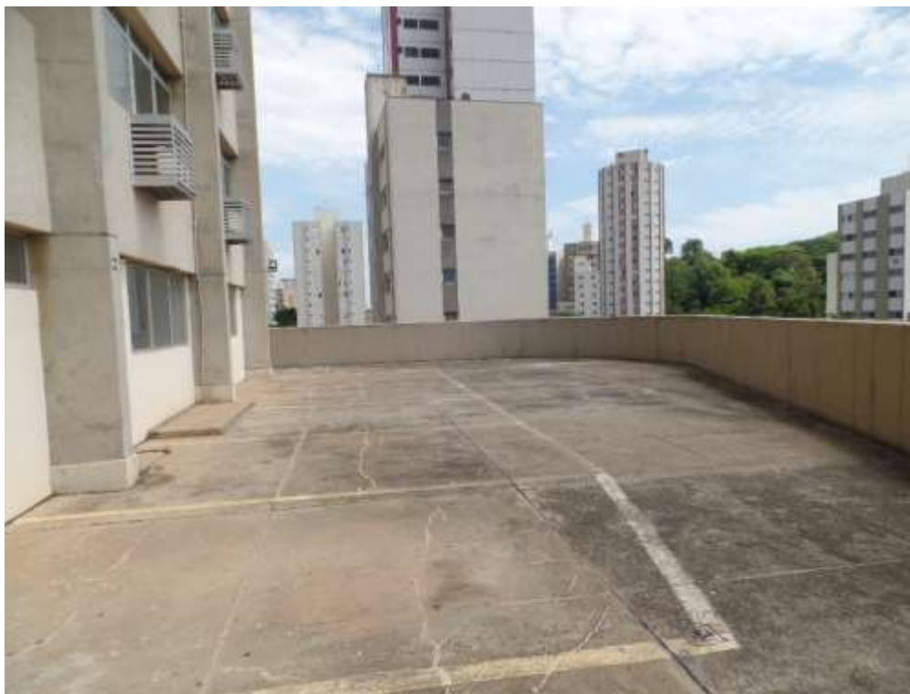
FOTO N.º 33- Tomada geral dos boxes de da garagem descobertas, com alteração do posicionamento.
