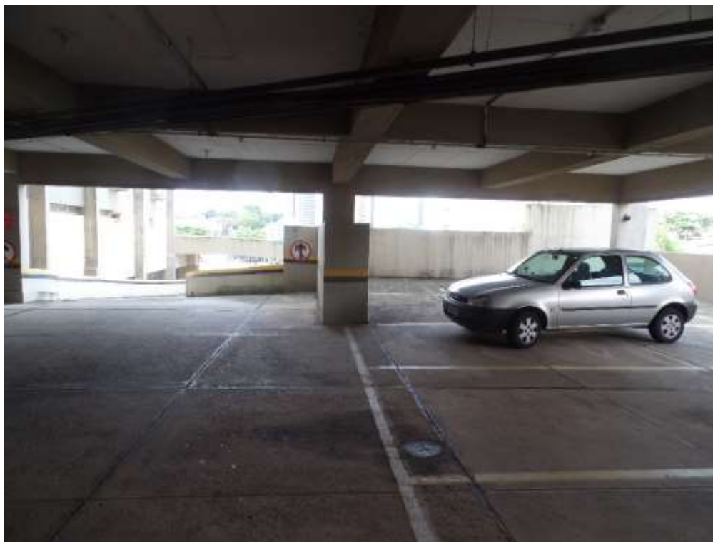
FOTO N.º 26- Vista interna dos boxes de garagens no pavimento intermediário.
