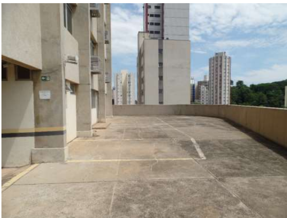
FOTO N.º 38- Vista geral dos boxes de da garagem descobertas, com alteração do posicionamento.
