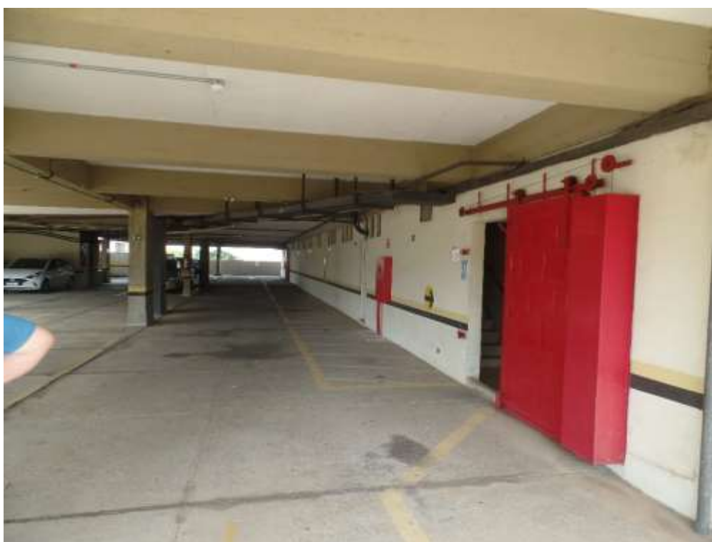
FOTO N.º 42- Detalhe da escada de acesso ao Bloco C e fechamento com paredes sendo feito escritório.
