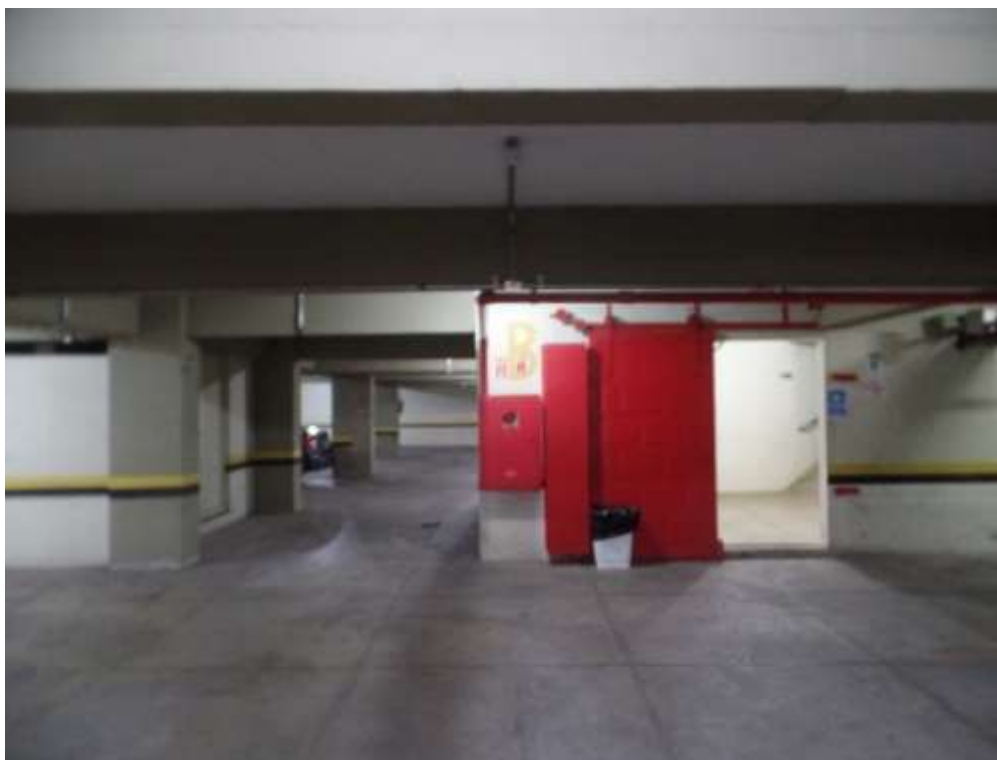
FOTO N.º 17- Vista da placa identificativa do bloco B no pavimento intermediário.
