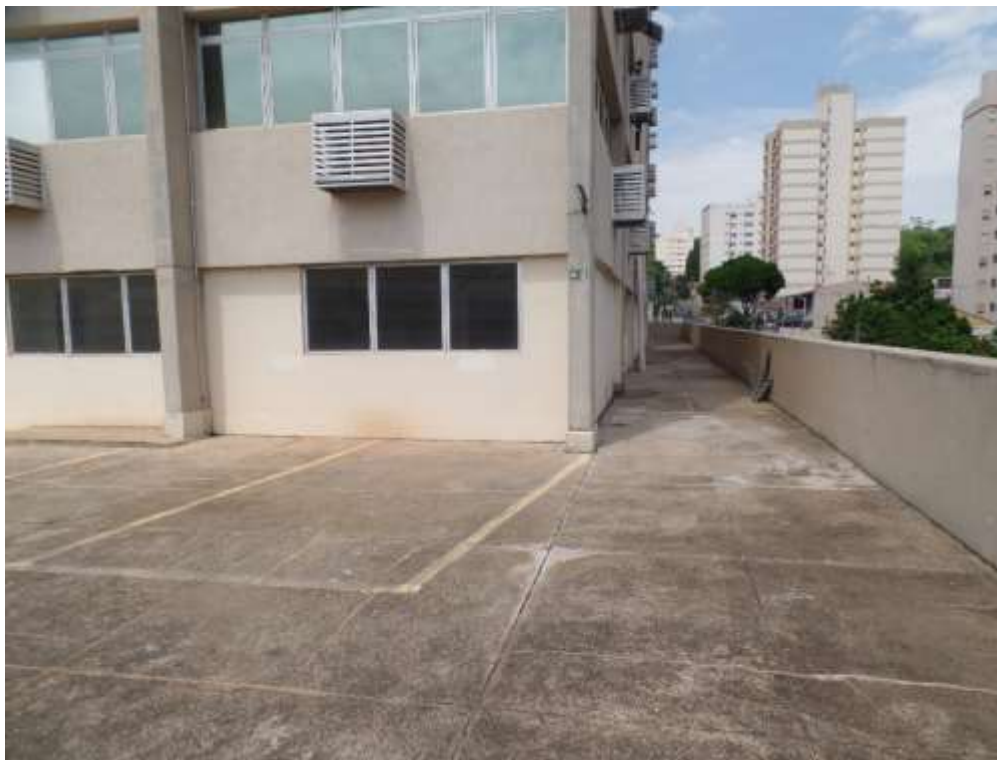
FOTO N.º 39- Vista do fechamento com paredes sendo feito escritório.
