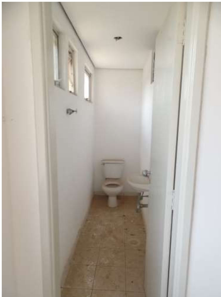
FOTO N.º 47- Vista interna do banheiro de n.º 01.
