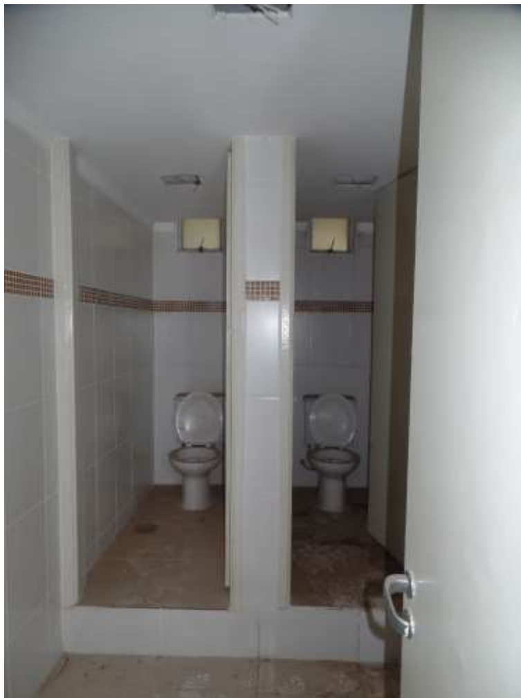
FOTO N.º 64- Tomada interna do banheiro de n.º 07.
