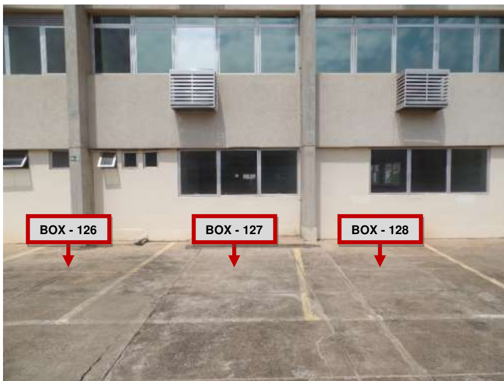
FOTO N.º 35- Detalhe do box de garagem de n.º 126, n.º 127 e n.º 128.
