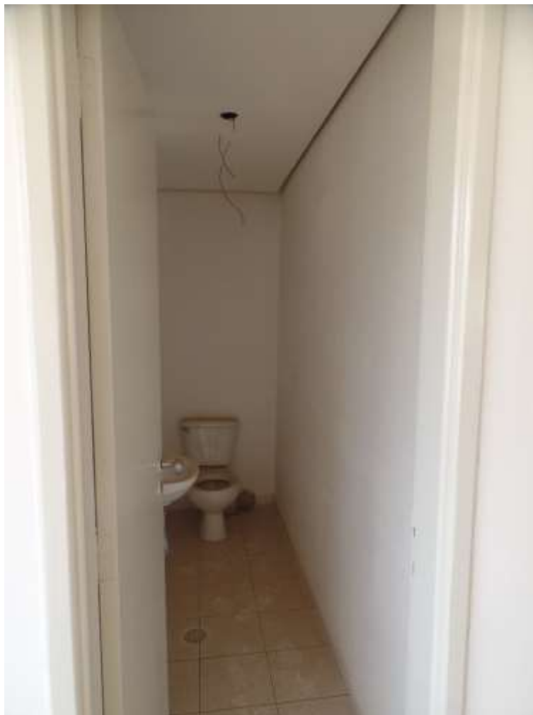
FOTO N.º 48- Tomada interna do banheiro de n.º 02.
