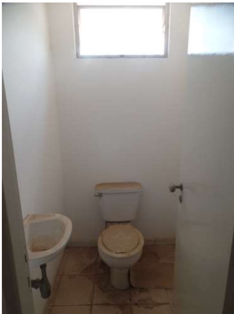
FOTO N.º 52- Tomada do banheiro de n.º 03.
