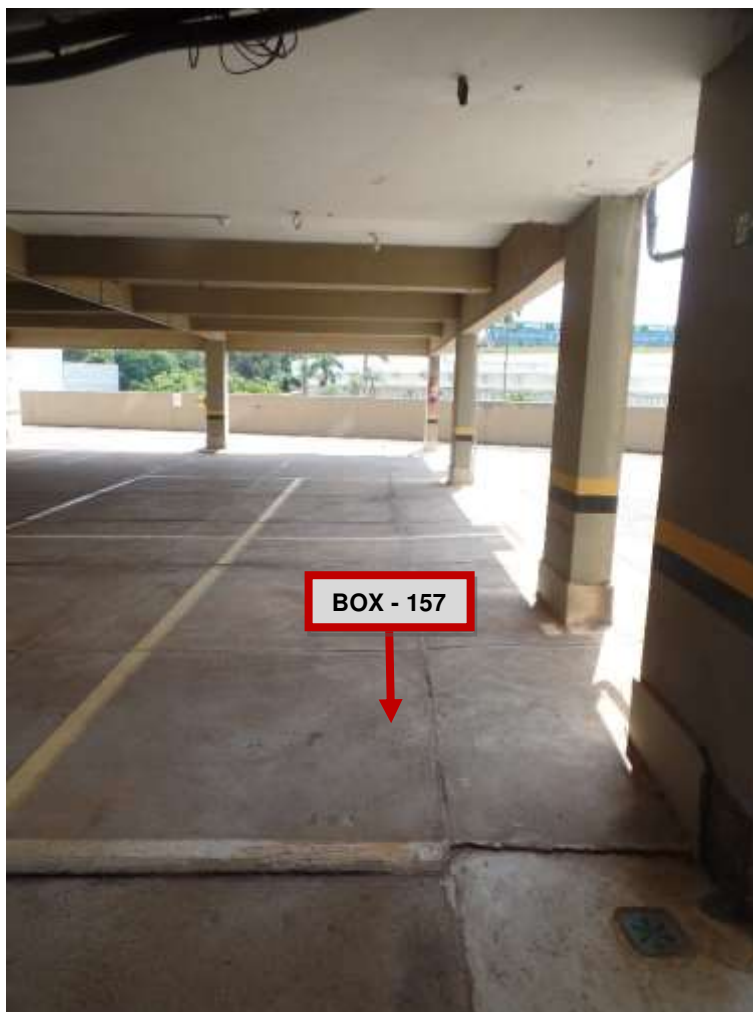
FOTO N.º 27- Vista do box de garagem de n.º 157.
