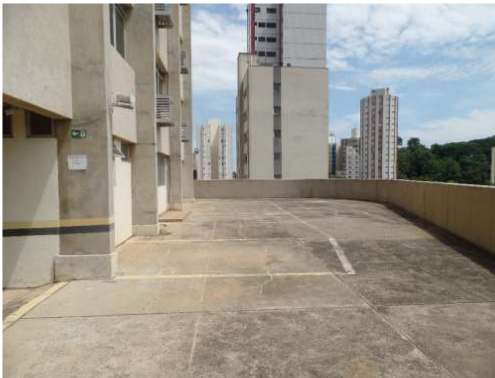
FOTO N.º 41- Tomada geral dos boxes de da garagem descobertas e fechamento com paredes sendo feito escritório.
