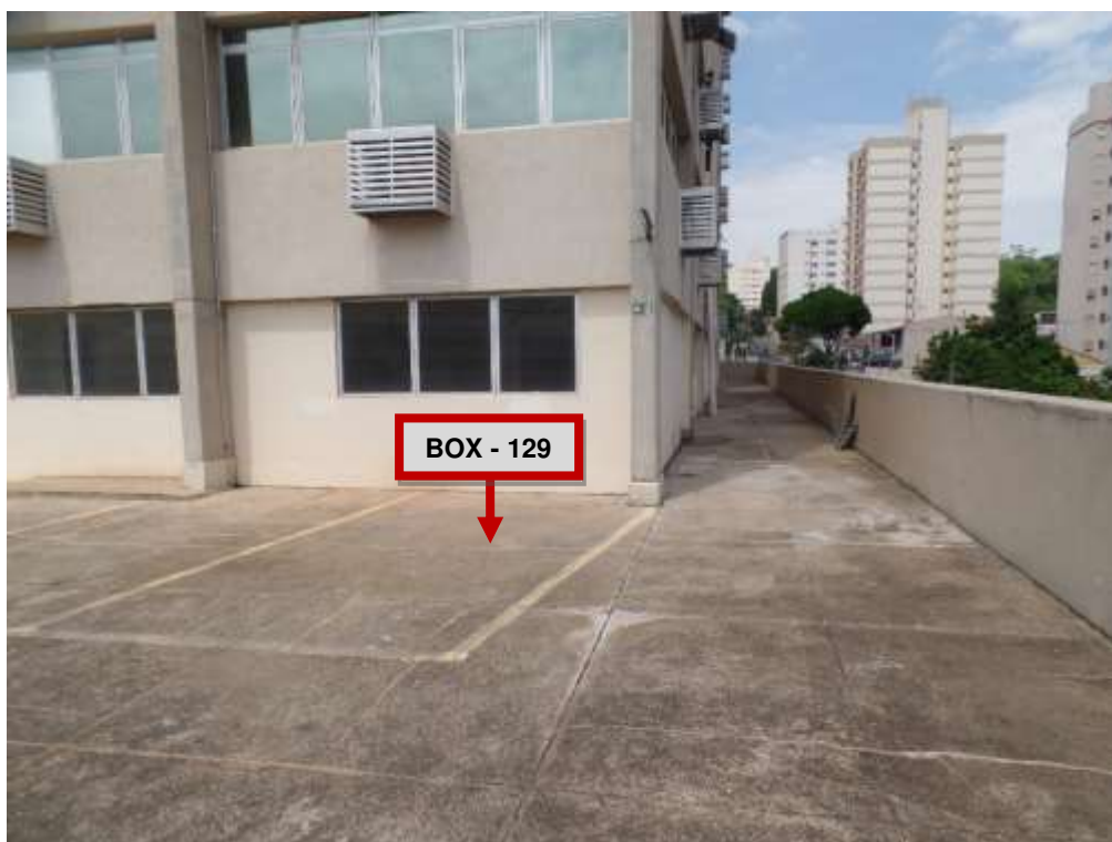
FOTO N.º 36- Vista do box de garagem de n.º 129.
