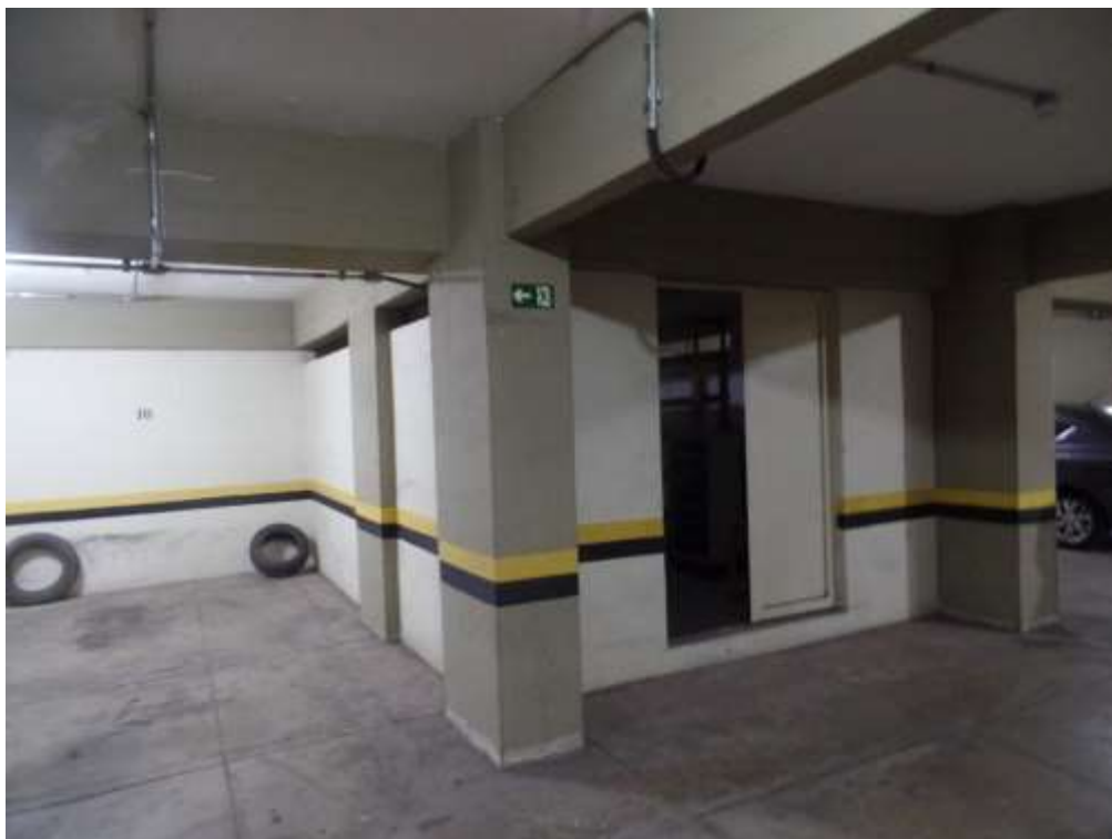
FOTO N.º 13- Vista do box de garagem de n.º 11, com fechamento com paredes em alvenaria, e portas de ferro, sendo utilizado como depósito.
