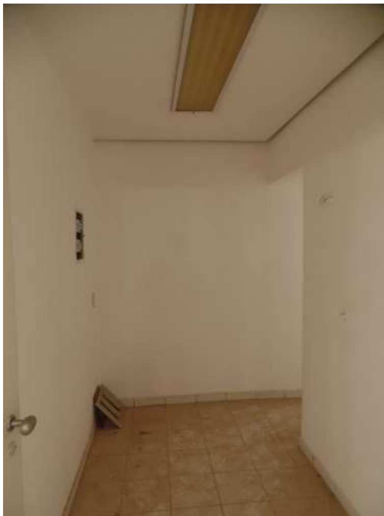
FOTO N.º 50- Detalhe interno da sala comercial.
