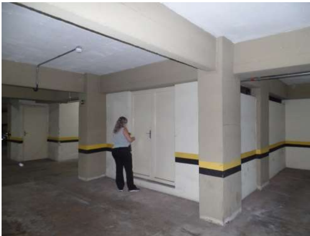
FOTO N.º 14- Tomada do box de garagem de n.º 11, com fechamento com paredes em alvenaria e porta de fedo, sendo utilizado como depósito.
