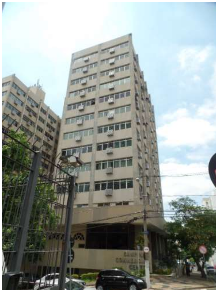
FOTO N.º 05- Tomada da fachada do Condomínio Governadores Gerais, esquina da Rua Uruguaiana e Rua Barão de Paranapanema.
