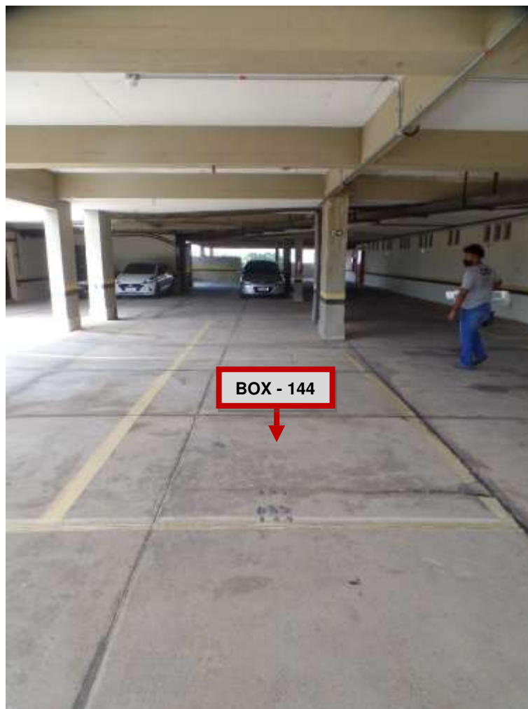
FOTO N.º 31- Vista do box de garagem de n.º 144.
