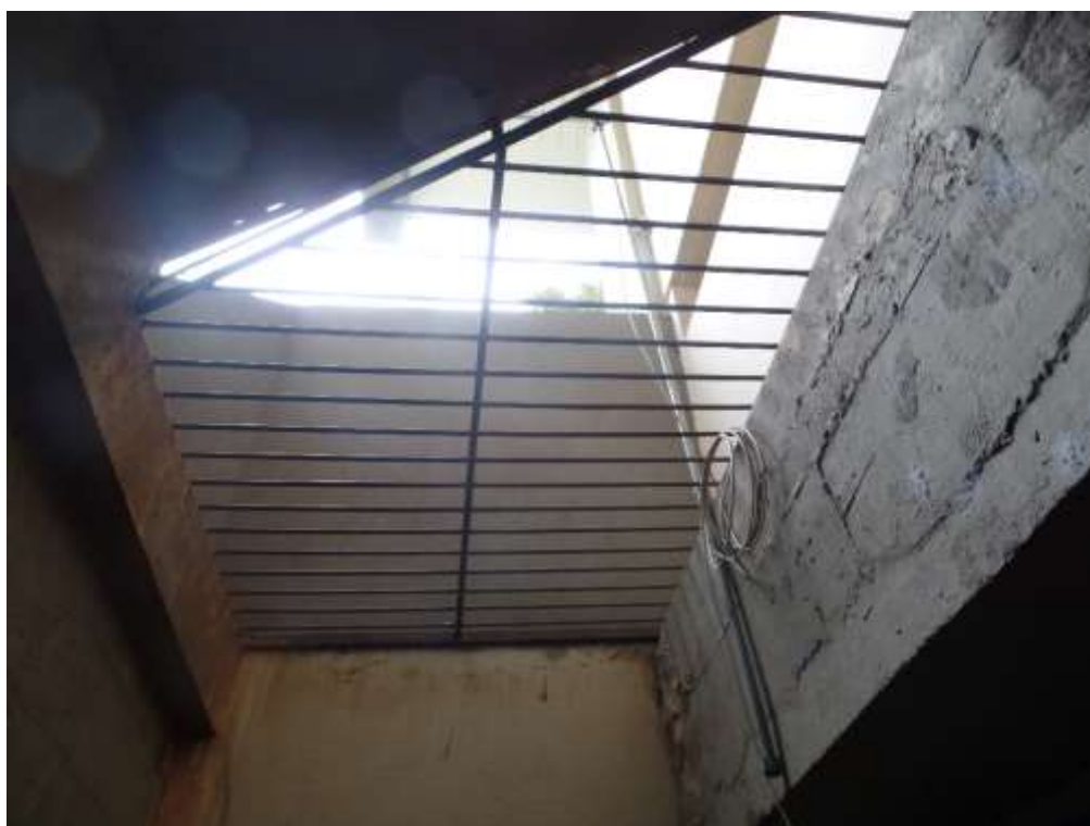
FOTO N.º 10- Vista da abertura para iluminação acima do box de garagem de n.º 54.
