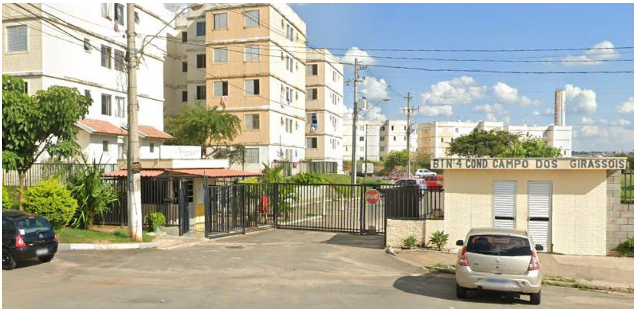
Foto no. 1- Vista da portaria do Condomínio.
