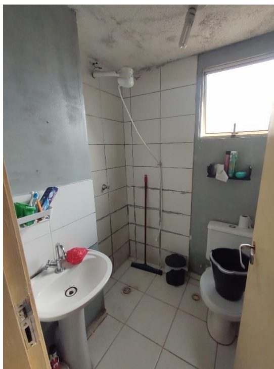
Foto no. 11 - Vista do banheiro.
