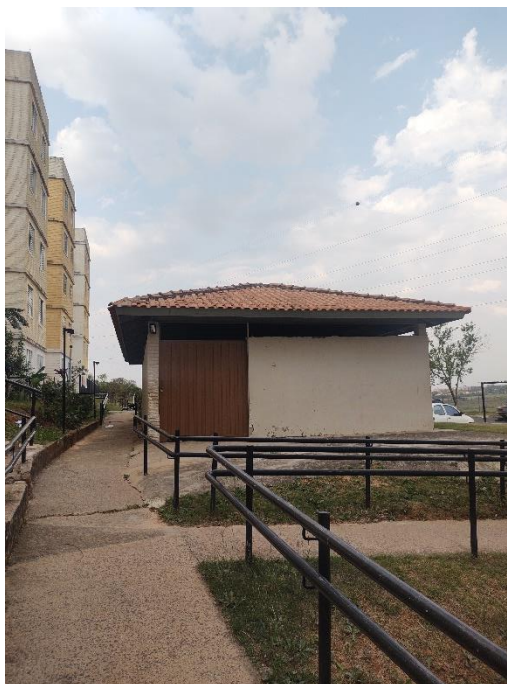
Fotos nos. 17 e 18 - Vista do salão.
