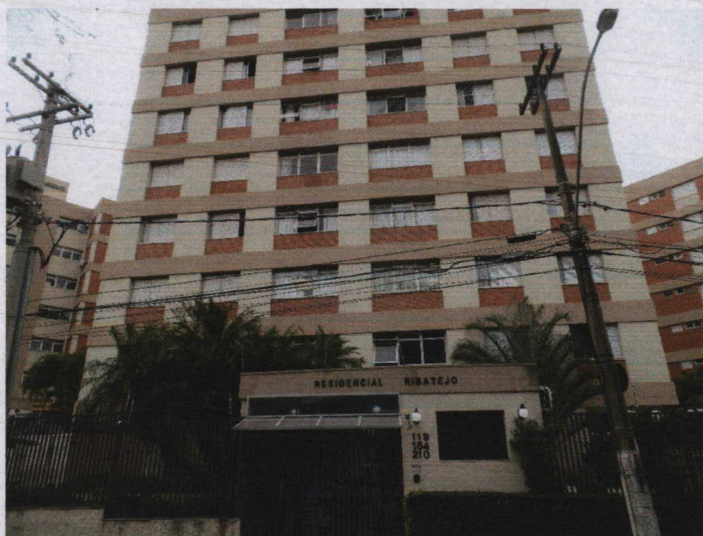
FOTO N.º 02- Vista da fachada do Edifício Residencial Ribatejo.
