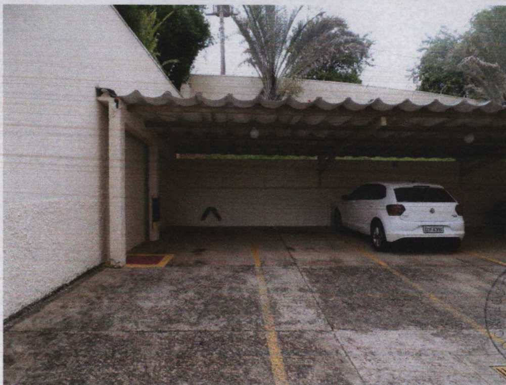
FOTO N.º 08- Aspecto da vaga de garagem n.º 49 coberta, pertencente ao apartamento n.º 141 – avaliando.
