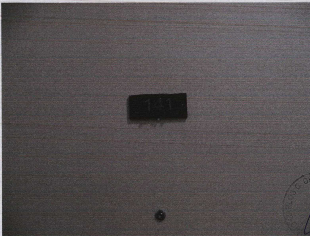
FOTO N.º 12- Detalhe da placa identificativa do apartamento n.º 141, onde não foi permitida a entrada no interior do imóvel apesar da Requerida ter sido devidamente notificadas.
