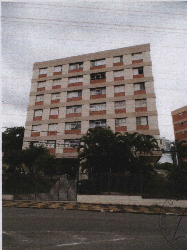
FOTO N.º 04- Vista da fachada do Edifício Barão da Torre, onde esta o imóvel avaliando.
