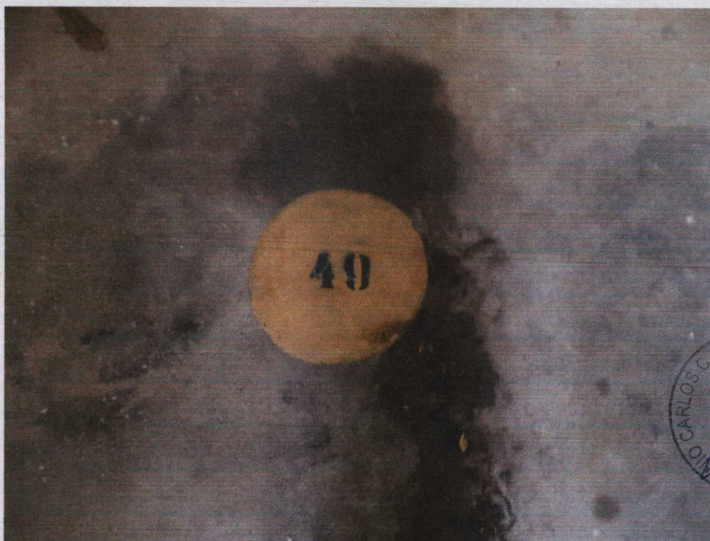
FOTO N.º 09- Detalhe da identificação da vaga de garagem coberta n.º 49.
