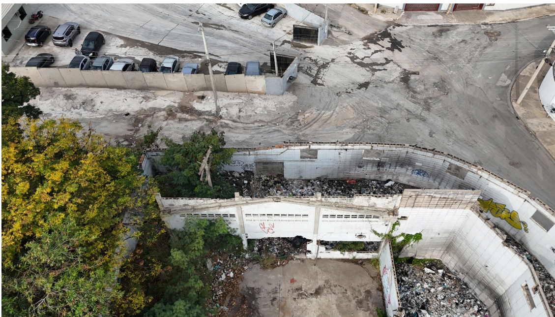
Imagem 10: Vista aérea dos fundos da edificação.
