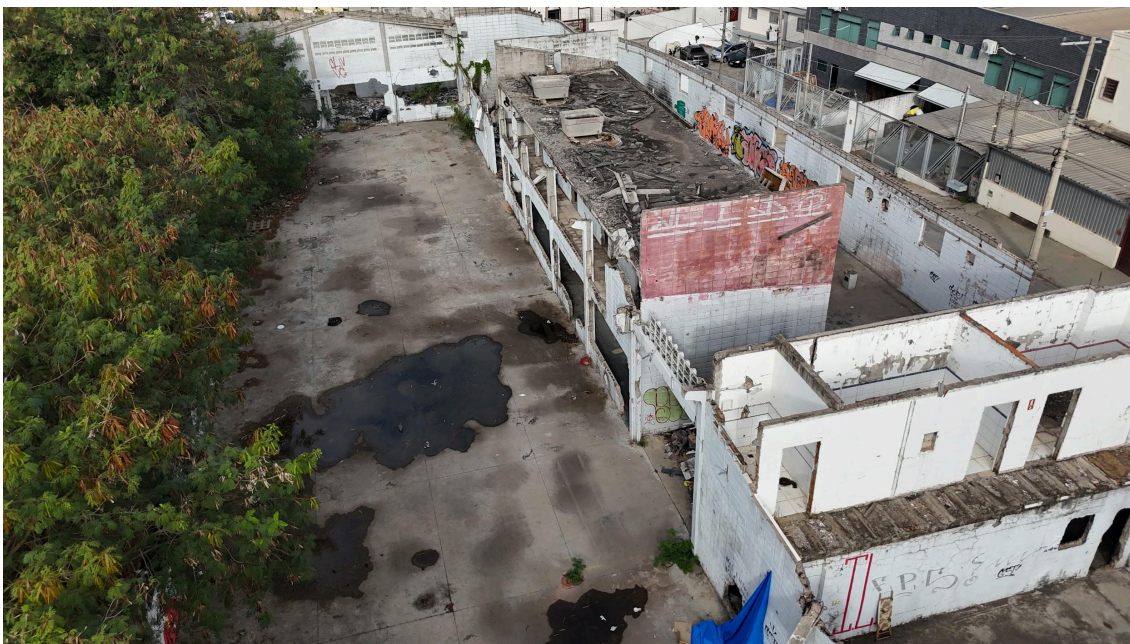
Imagem 8: Vista aérea do lateral.
