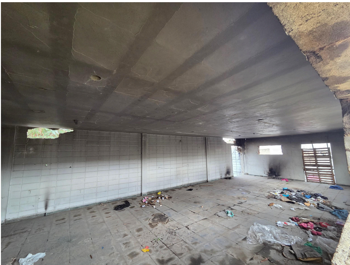
Imagem 3: Visão interna da construção vista na imagem 2.
