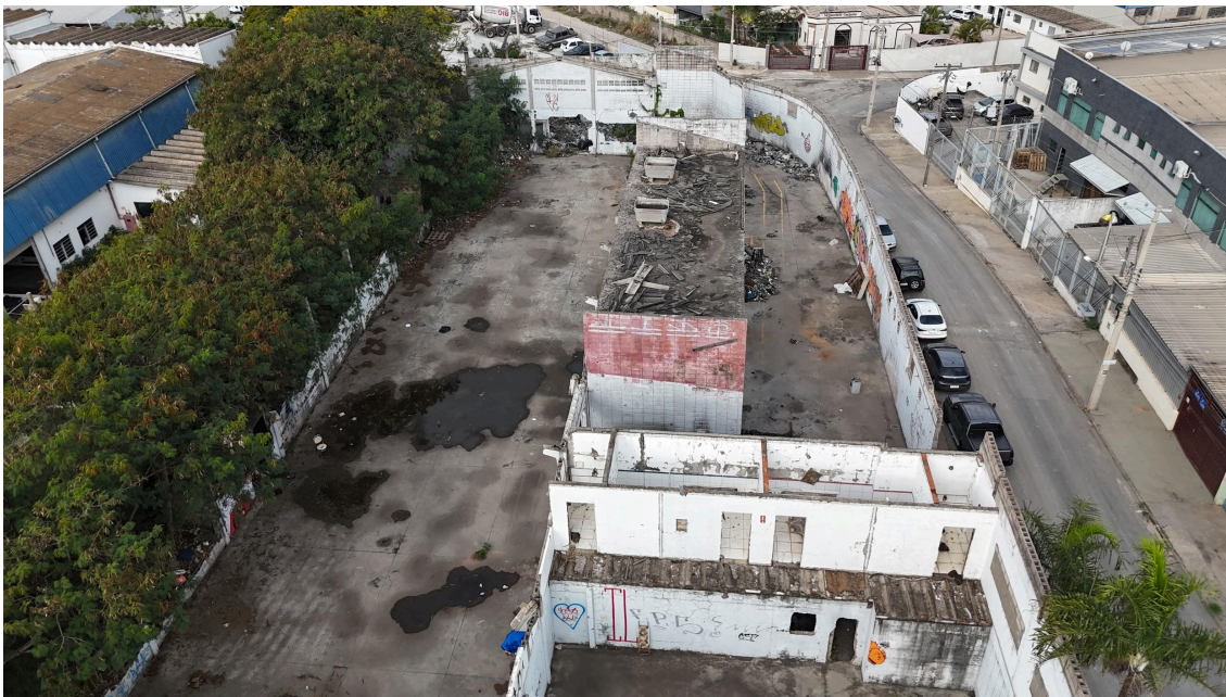
Imagem 7: Visão superior da edificação.
