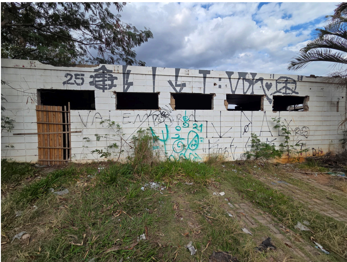
Imagem 2: Vista da fachada da R. Jovelino Aparecido Miguel.
