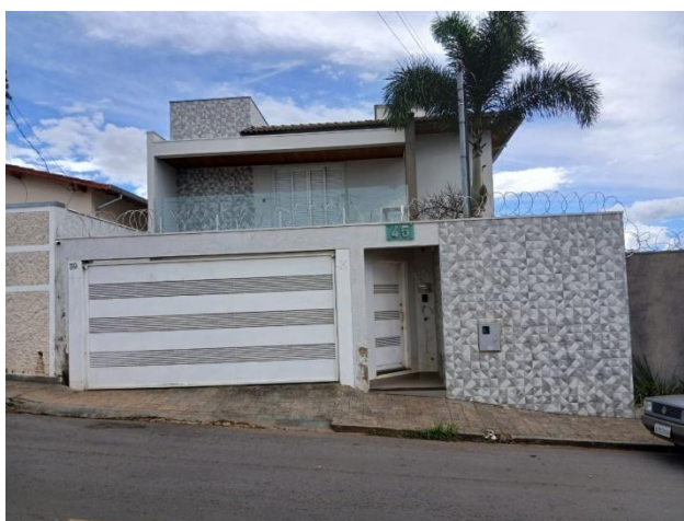
Vista do Imóvel Avaliando
