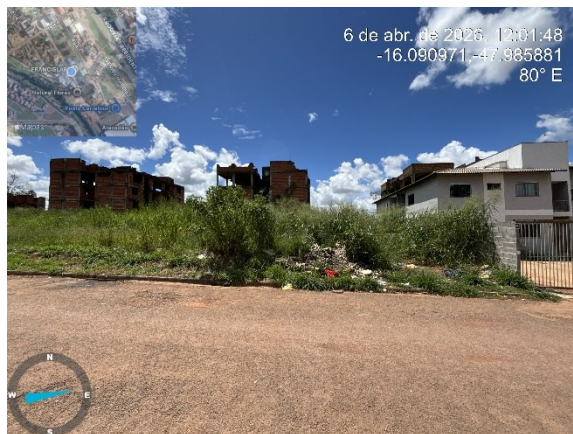
02) FACHADA PRINCIPAL (NW)
