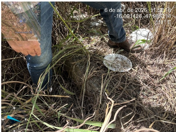
11) FUNDAÇÃO DO LOTE VISÍVEL
