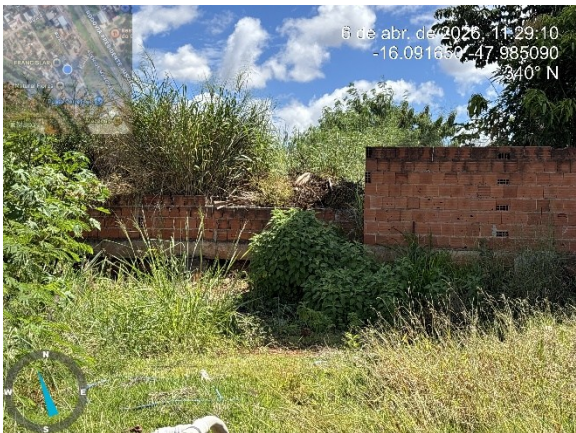
10) FUNDAÇÃO DO LOTE VISÍVEL
