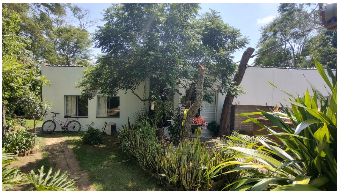
Fachada casa sede
