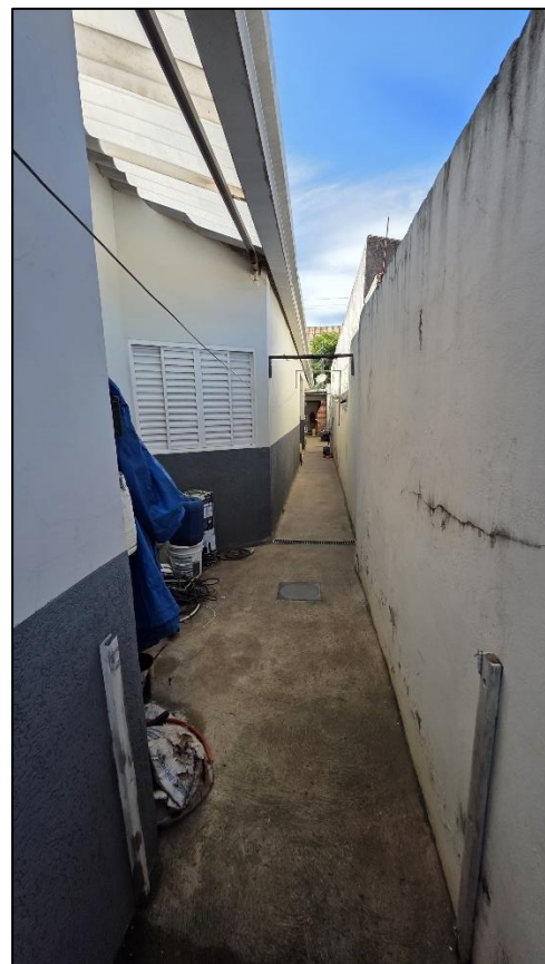
Imagem 39: Fundos do imóvel. Presença de trinca no muro dos fundos.
