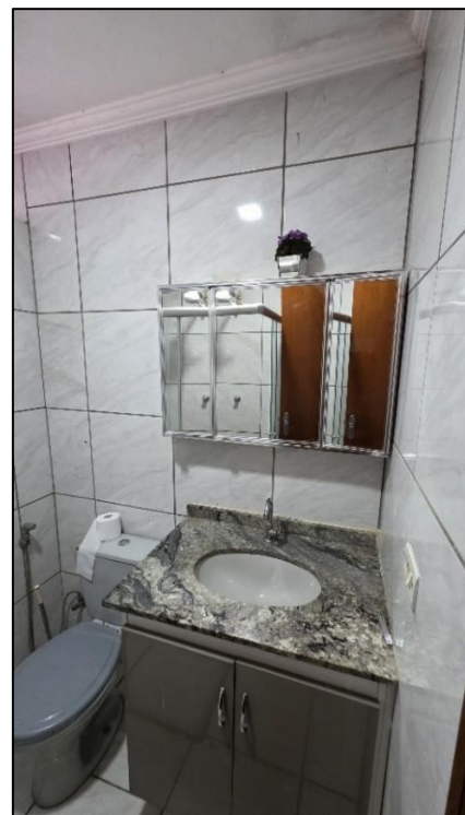
Imagem 18: Banheiro social, com piso e paredes revestidos em cerâmica e laje com reboco e pintura.
