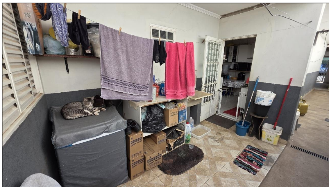
Imagem 37: Área de serviço da casa n.º 597 com piso cerâmico e paredes e laje com reboco sob pintura.
