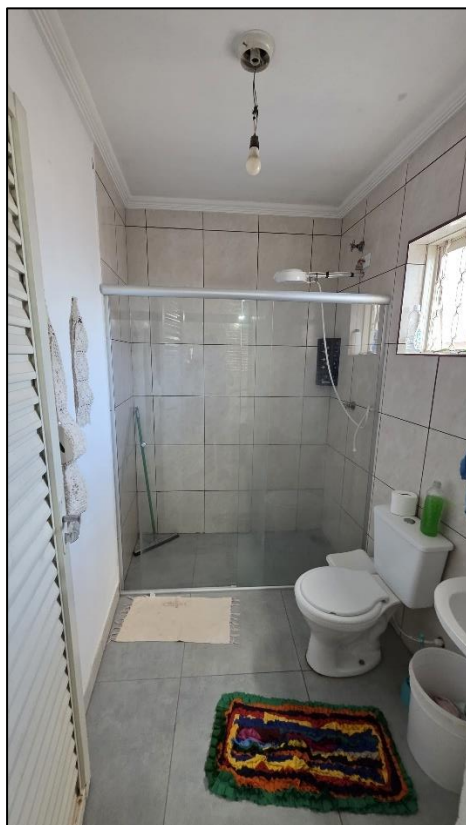
Imagem 42: Banheiro suíte (quarto 01) da casa n.º 597 com piso, paredes parcialmente com cerâmica e teto em laje com acabamento em gesso.
