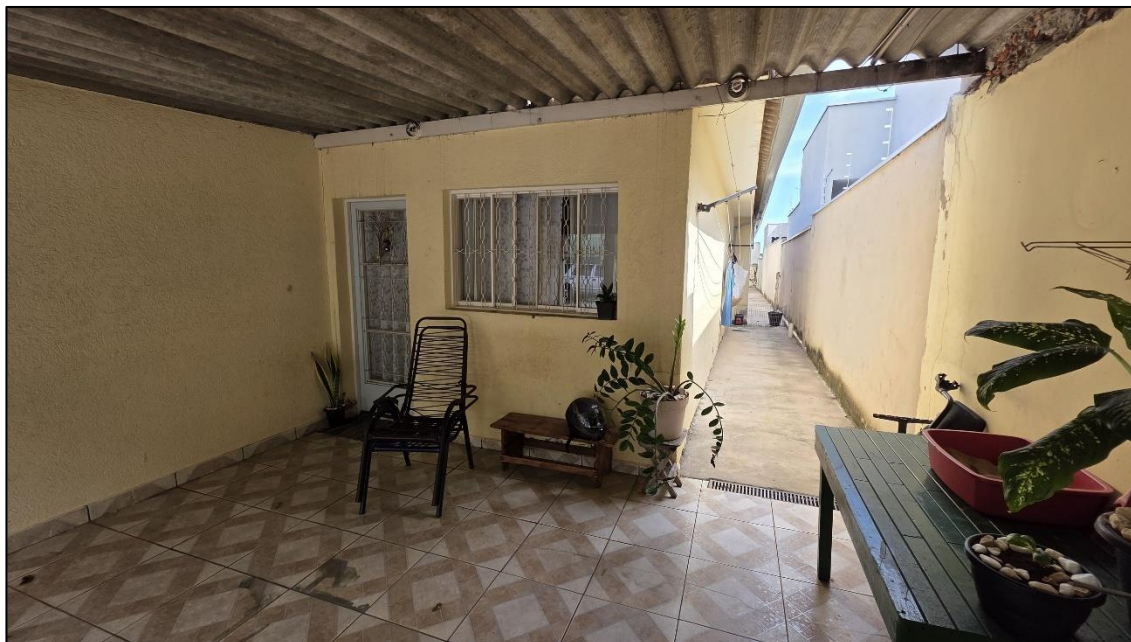
Imagem 44: Garagem da casa n.º 601 com vaga para 01 (um) carro, piso cerâmico, paredes rebocadas com pintura e cobertura leve.
