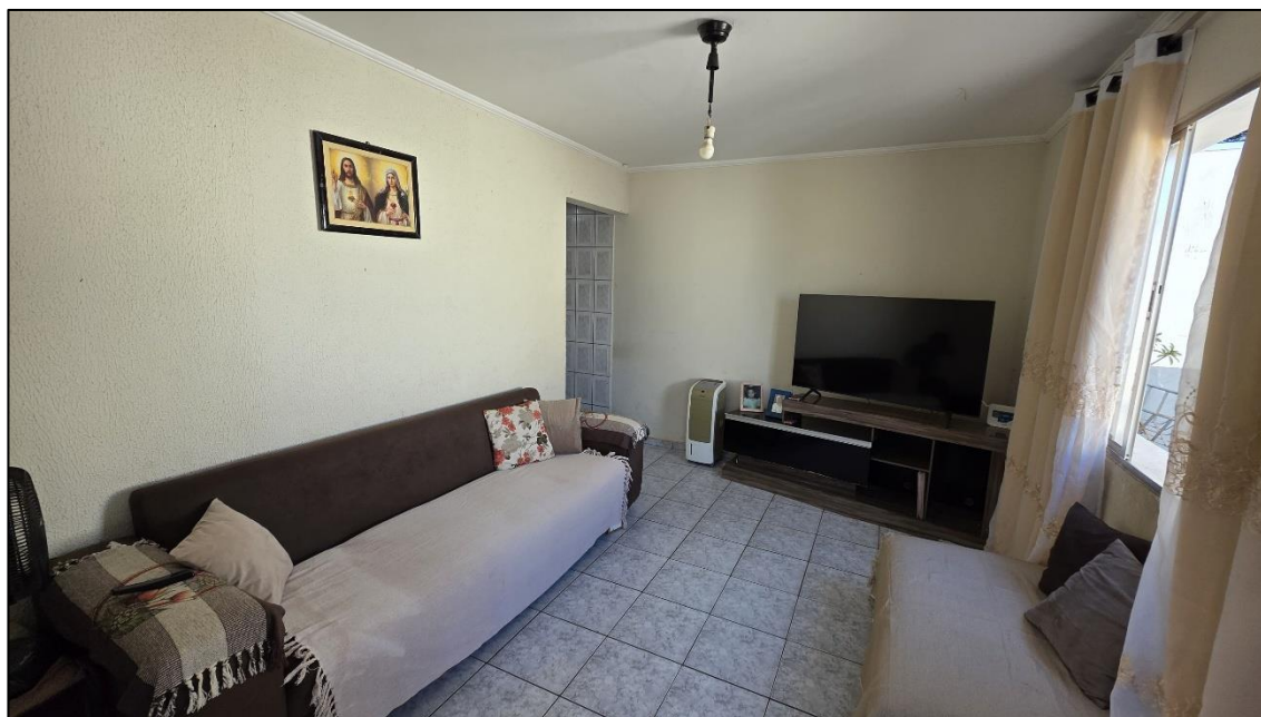
Imagem 11: Sala de estar e TV com piso cerâmico, paredes e laje rebocados com pintura e moldura de gesso.
