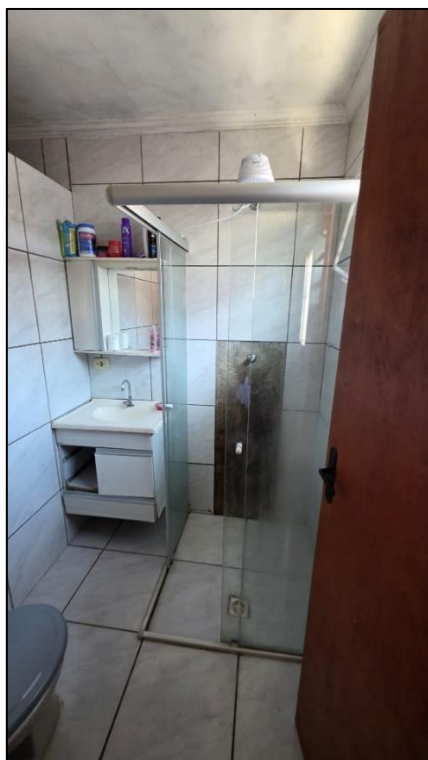
Imagem 21: Banheiro da suíte (quarto 02), com piso e paredes revestidos em cerâmica e teto em laje com acabamento em gesso. Falta de acabamento de azulejos na parede do box.
