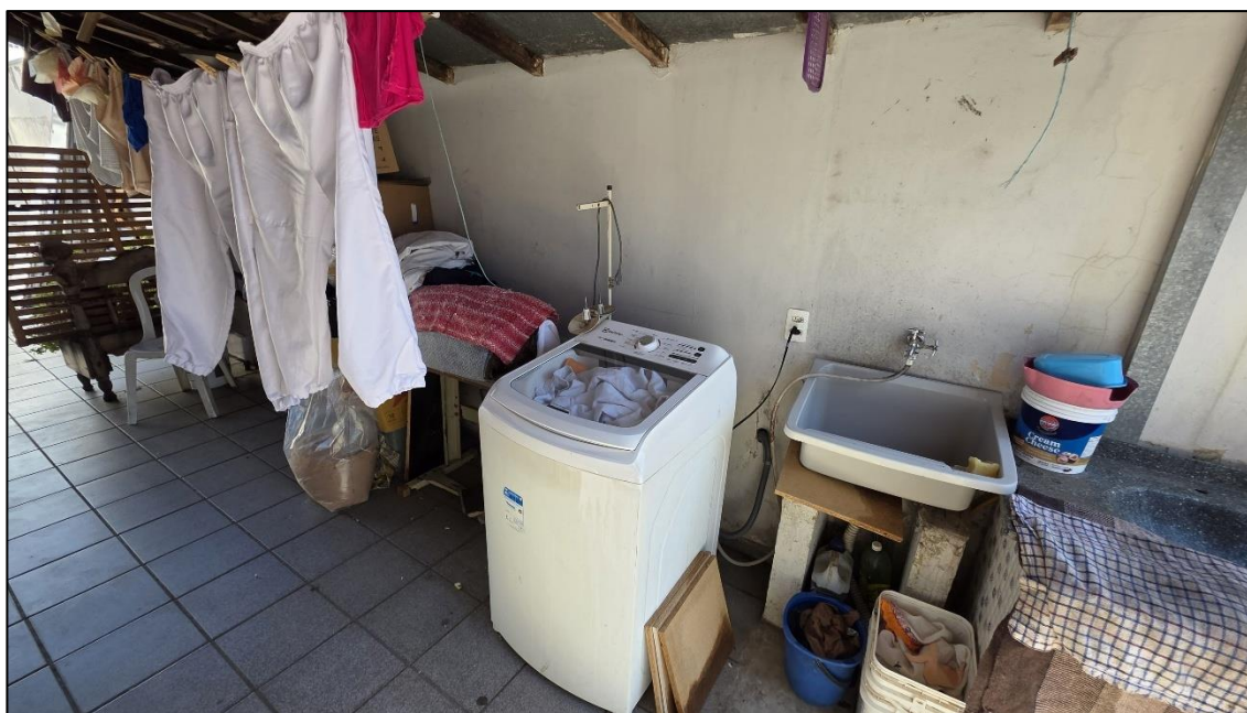
Imagem 24: Área de serviço localizada na lateral do imóvel contendo: piso cerâmico, paredes com reboco e pintura e cobertura leve.
