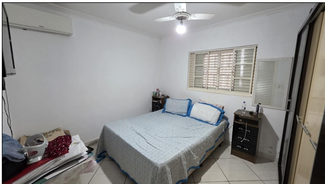
Imagem 40: Quarto 01 (suíte) da casa n.º 597 com piso cerâmico, paredes e laje com reboco e pintura e acabamento em gesso.
