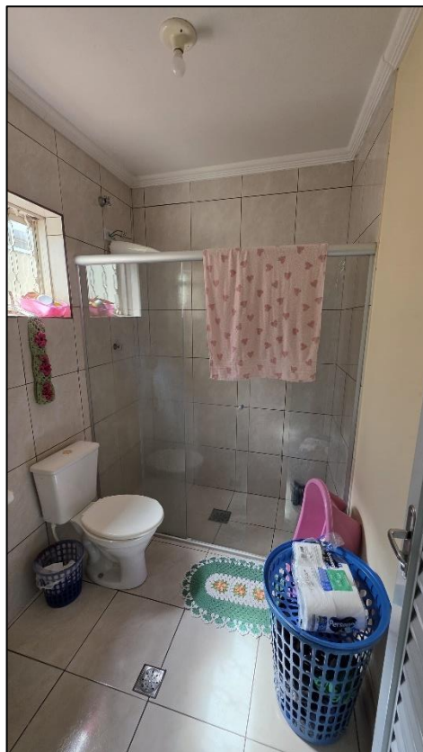
Imagem 55: Banheiro da suíte (quarto 03) com piso e paredes revestidos em cerâmica e laje com reboco e pintura.
