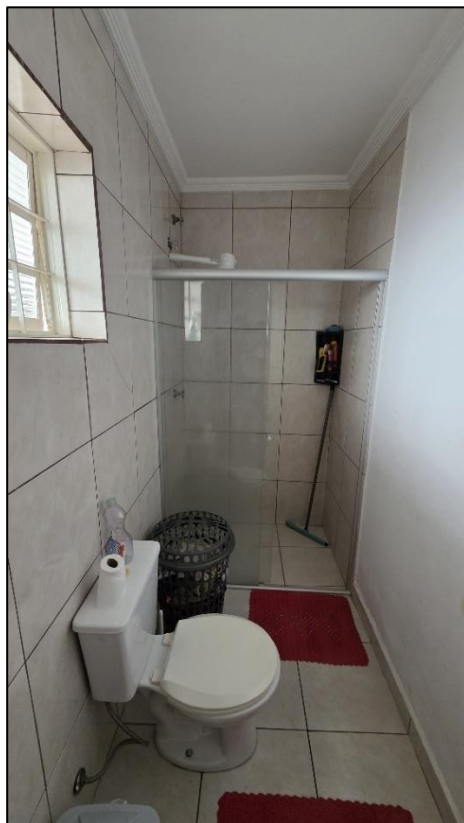
Imagem 36: Banheiro social da casa n.º 597 com piso, paredes parcialmente revestidas em cerâmica e teto em laje com acabamento em gesso.
