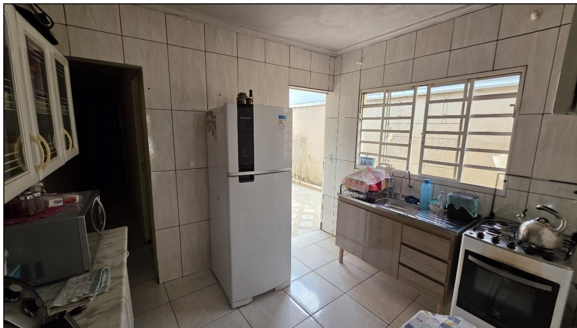
Imagem 47: Cozinha com piso e paredes revestidos em cerâmica, e teto em laje com reboco e pintura.
