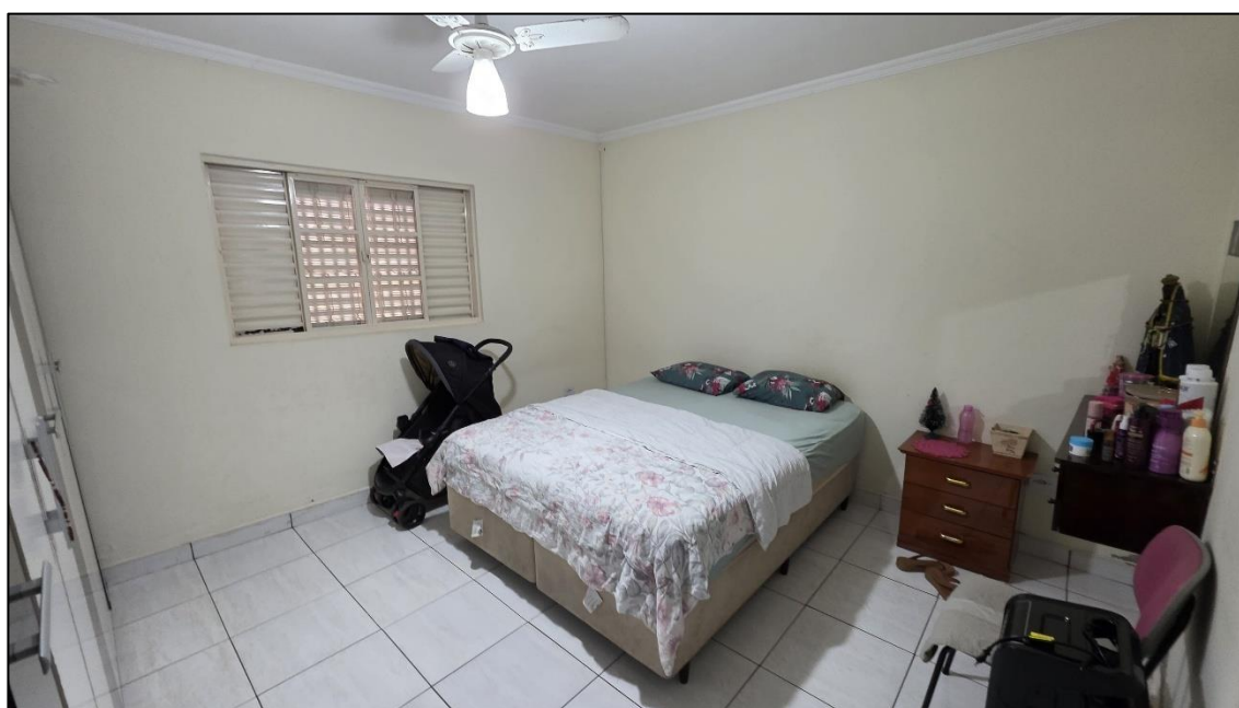
Imagem 53: Quarto 03 (suíte), com piso cerâmico, paredes e laje rebocados com pintura e moldura de gesso.
