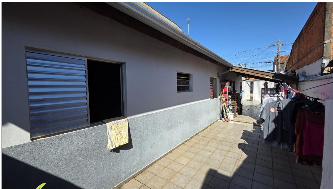
Imagem 23: Lateral do imóvel com vista para a frente, contendo piso cerâmico, paredes com reboco e pintura sem cobertura.
