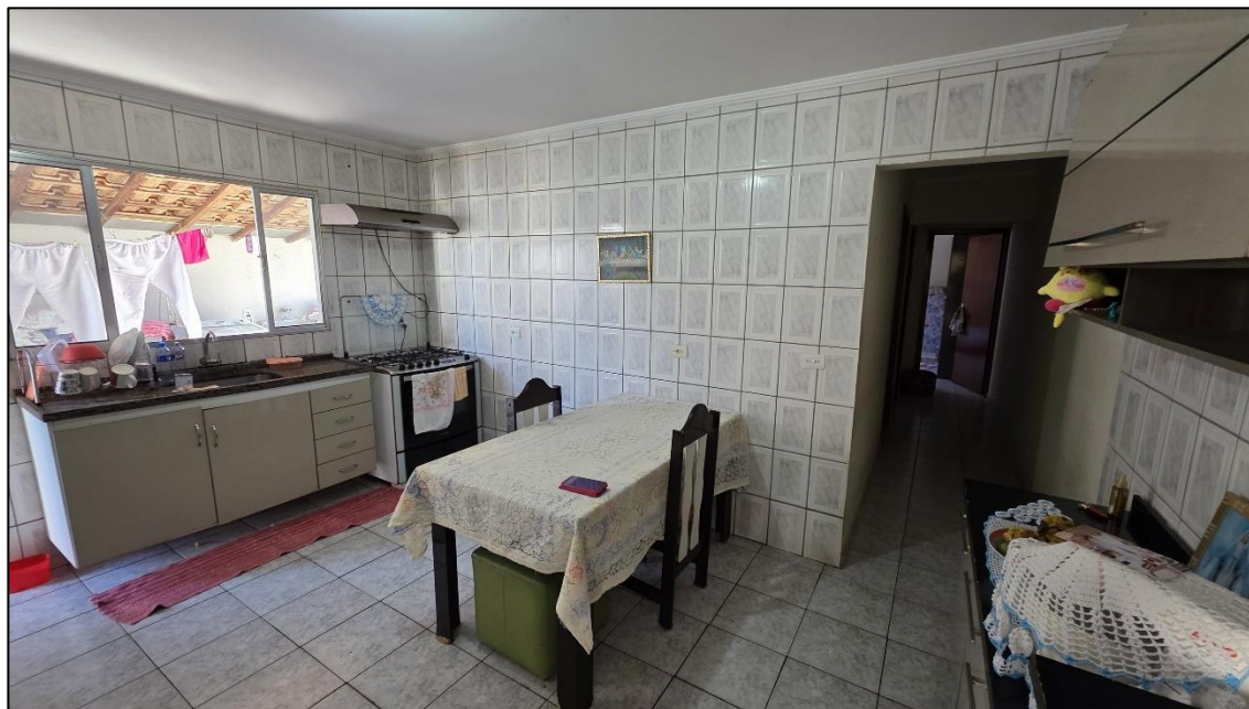
Imagem 13: Cozinha com piso e paredes revestidos em cerâmica, teto rebocado com pintura e moldura de gesso.
