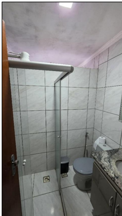
Imagem 18: Banheiro social, com piso e paredes revestidos em cerâmica e laje com reboco e pintura.
