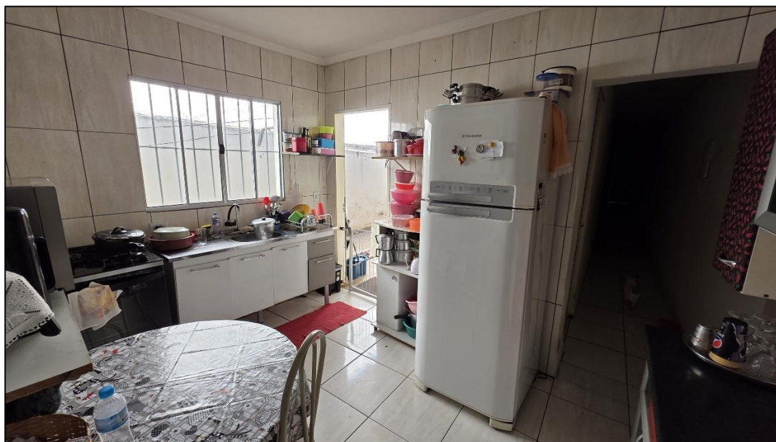
Imagem 35: Cozinha da casa n.º 597 com piso e paredes revestidos em cerâmica, teto em laje com reboco e pintura e acabamento em gesso.
