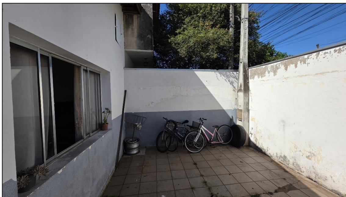
Imagem 10: Vista para o recuo frontal do imóvel com piso cerâmico e paredes com reboco e pintura.
