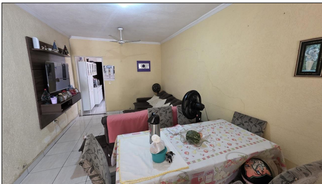
Imagem 45: Sala de estar/TV com piso cerâmico, paredes e laje com reboco sob pintura e acabamento em gesso.
