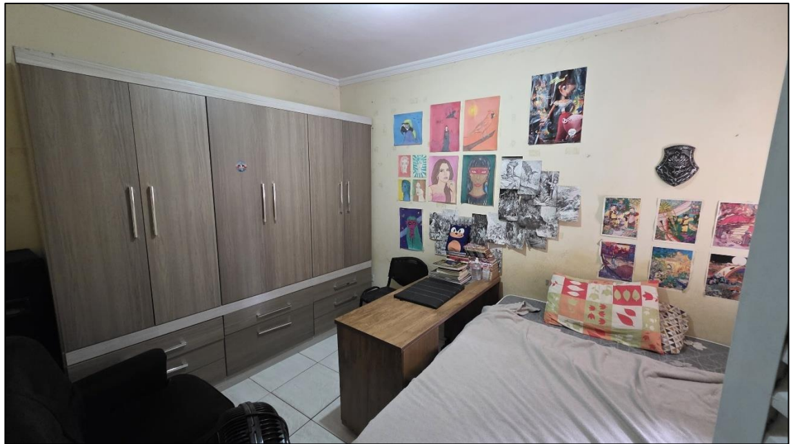
Imagem 50: Quarto 01 com piso cerâmico, paredes e laje rebocados com pintura e moldura de gesso.
