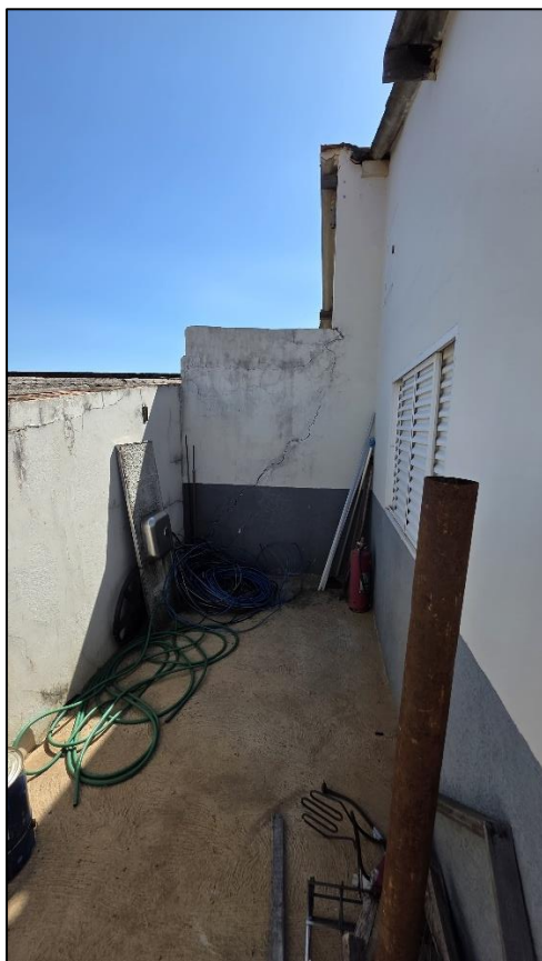
Imagem 39: Fundos do imóvel. Presença de trinca no muro dos fundos.
