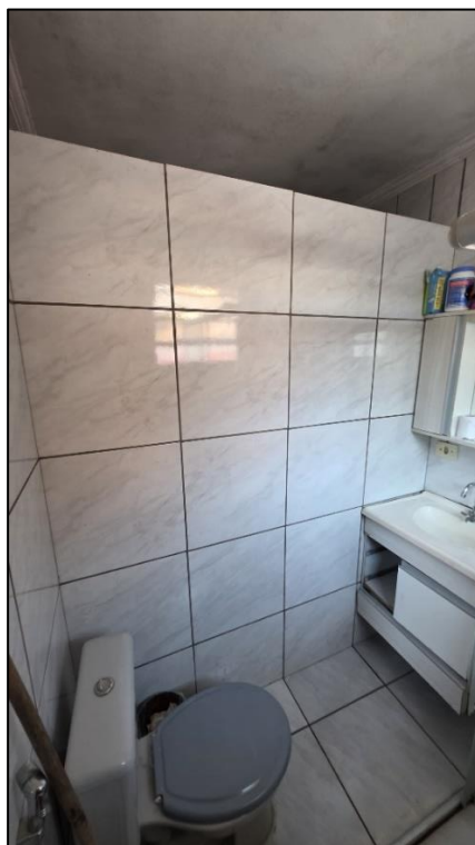
Imagem 21: Banheiro da suíte (quarto 02), com piso e paredes revestidos em cerâmica e teto em laje com acabamento em gesso. Falta de acabamento de azulejos na parede do box.
