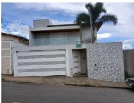
Vista do Imóvel Avaliando
